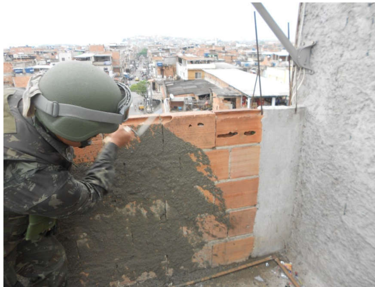
FÍGURA 3 – Reforma em muro de alvenaria
