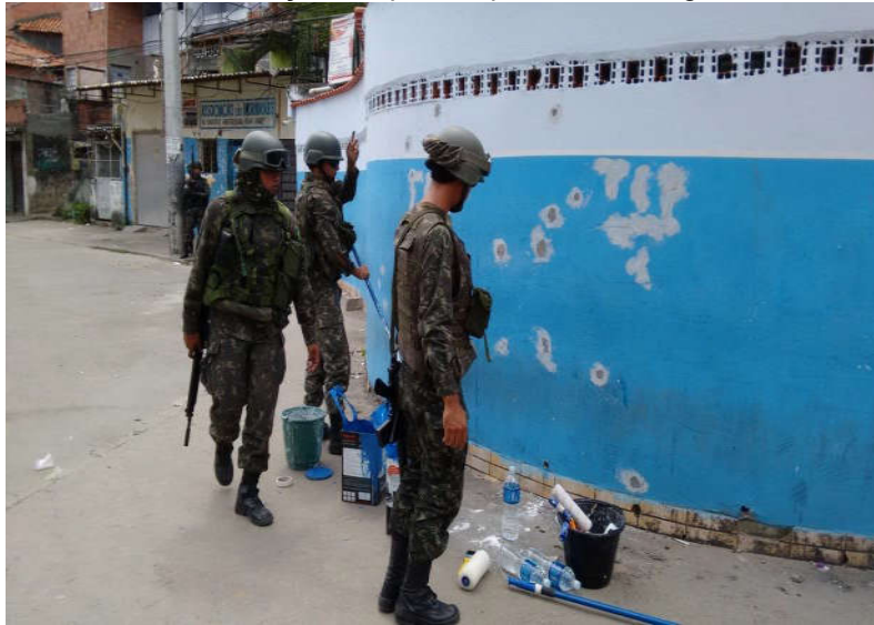
FÍGURA 2 – Perfuração em parede por arma de fogo
